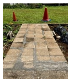
セメント補強
