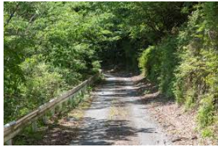
車のすれ違いも厳しい国道 77号線 緊張の連続
