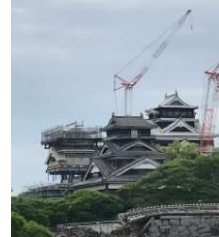
地震で崩落 熊本城
