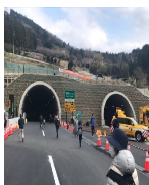
羽根トンネル
