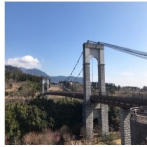
戸川 風の吊橋
