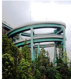
河津七滝ループ橋
